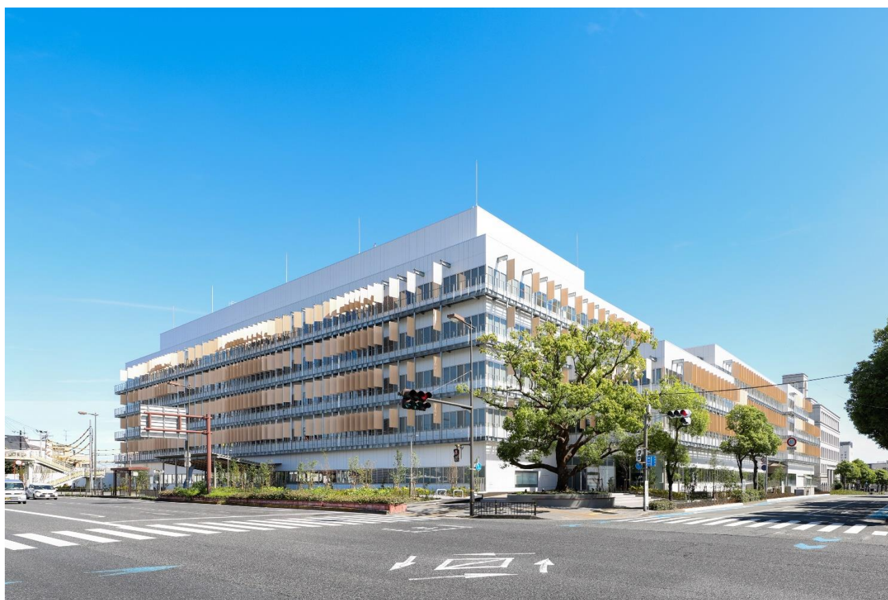
（伊丹市役所 本庁舎）
